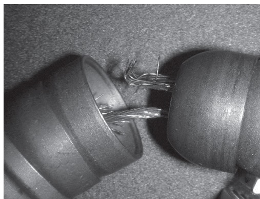
Hình 4 – Cáp bị hư hỏng – KHÔNG SỬ DỤNG
